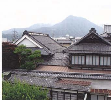
保存改修することとなった大本願明照殿と御物見
